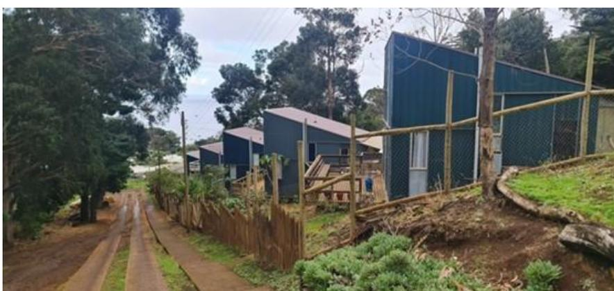
La materialidad se concibió en base a fundaciones de pino impregnado tipo pilotes, losas de madera laminada, paneles prefabricados (TecnoPanel), ventanas de aluminio, cubiertas prefabricadas (Instapanel) y forros exteriores de acero microondulado (Hunter Douglas).
